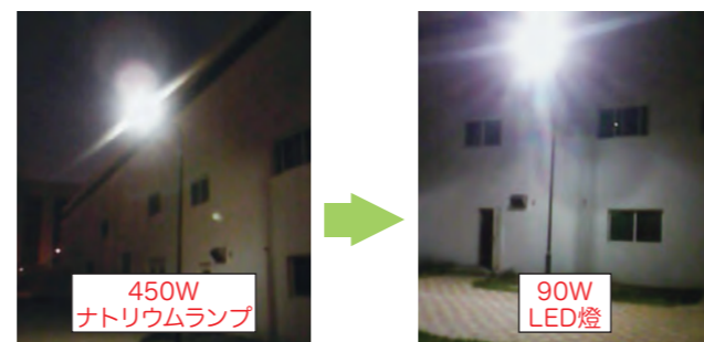
構内外灯のナトリウムランプ 22 灯をLED燈へ変更。
