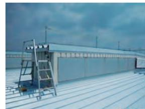
工場の屋根に遮熱塗装をして、室温の上昇を抑制
