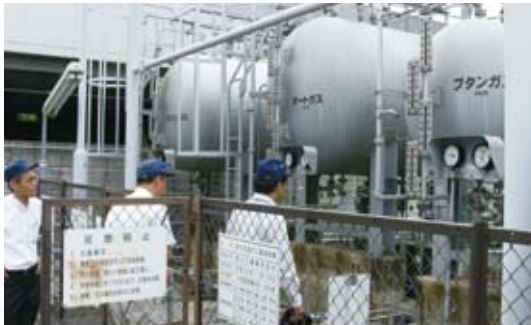
安全点検で危険箇所の洗い出し
