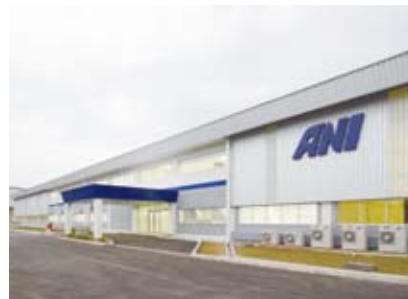
完成した第2工場【2010年10月 竣工】
