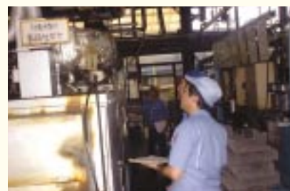
設備の省エネ点検
