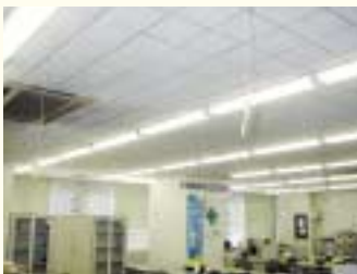
◀取替えられた蛍光灯
