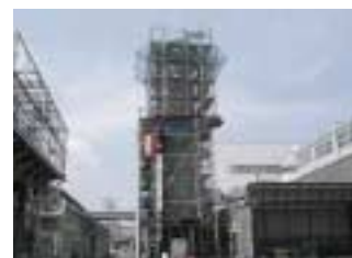
燃料転換に伴い煙突改修
