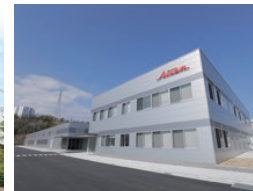
広瀬テクニカルセンター
