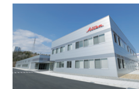
広瀬テクニカルセンター
