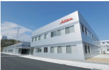
広瀬テクニカルセンター
