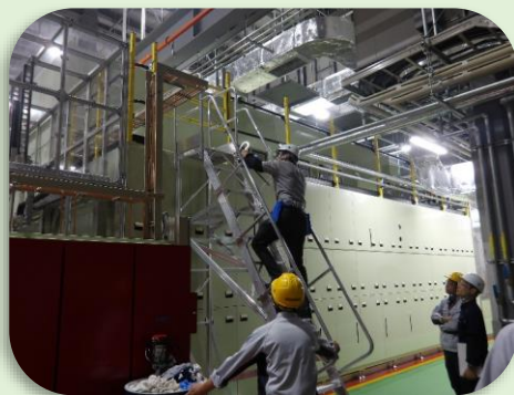
新工場の危険源洗い出し
