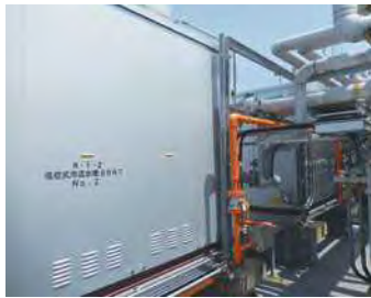
インバーター制御式吸収式冷水機
