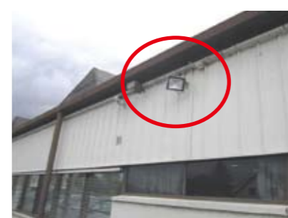
工場建屋の外灯を省エネタイプの機器に更新(AIF:フランス)
