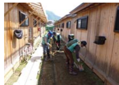
仮設住宅の排水溝整備
