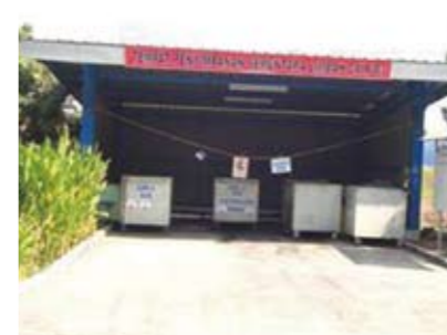
廃油タンク置き場の屋根、外壁設置とコンクリート舗装による漏洩防止(ANI:インドネシア)
