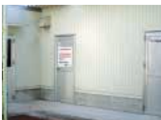
PCB廃棄物保管倉庫
